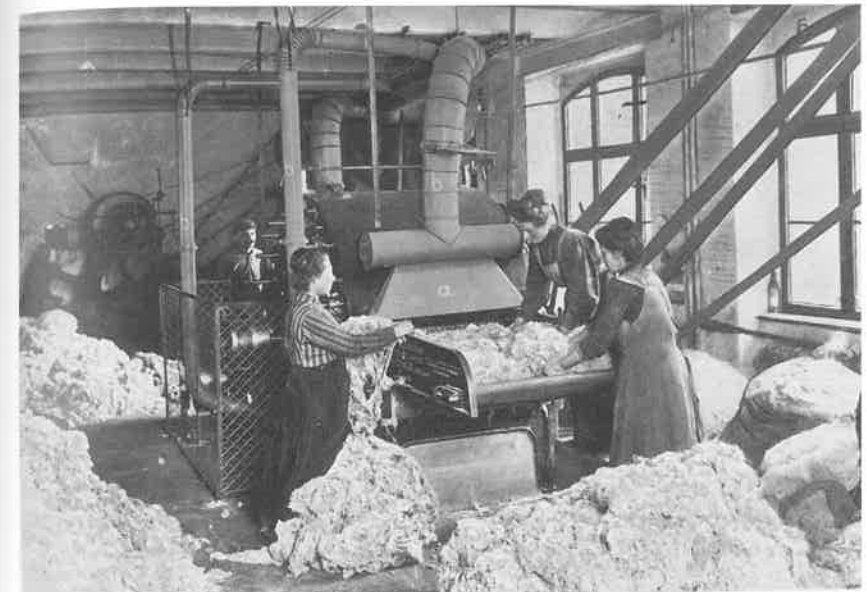
Haderneissmaschine mit Absaugvorrichtung, Darstellung aus Sommerfeld, S. 95
